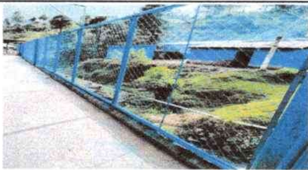
Foto 3: Sustitución de Perímetro de Circulación
