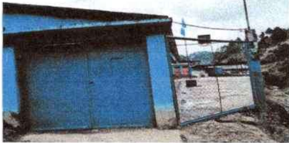
Foto 1. Sustitución de portón de metal
