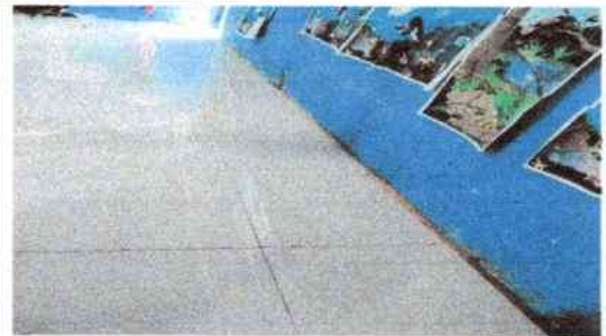
Foto 2. Sustitución de piso
